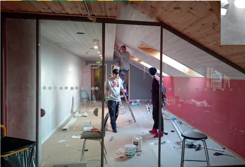
DSC & IMG: En ivrig dugnadsjeng er godt igang med malearbeidet!
